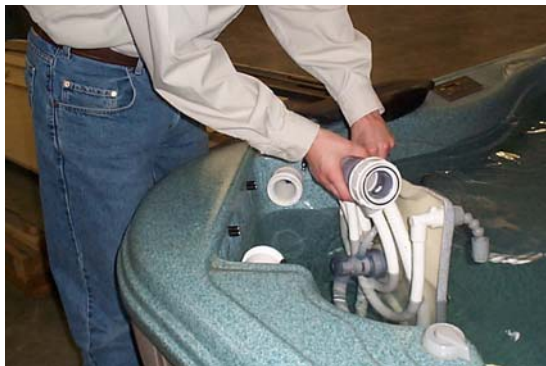
(Figure P) Removing a JetPak
